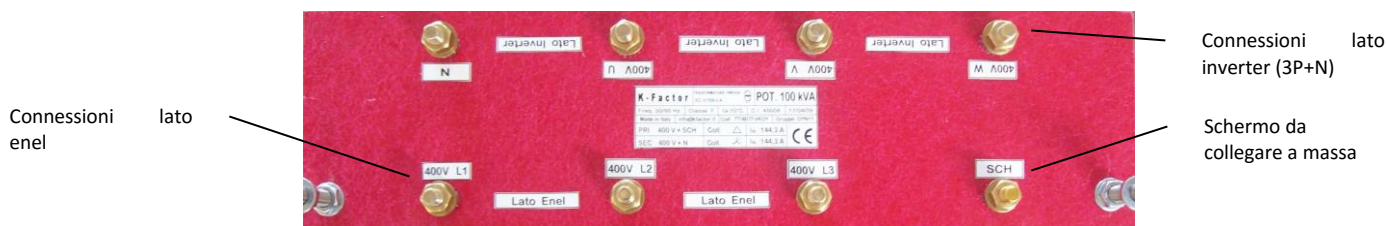
Tipica piastra collegamenti dei modelli TTI-FV (nella foto il collegamento Dyn11)
