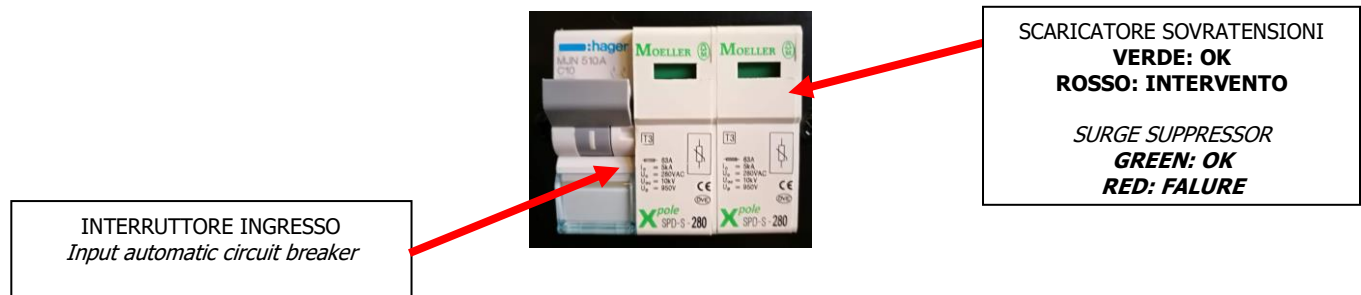
FIG. 4 INTERRUTTORE INGRESSO E SCARICATORE DI SOVRATENSIONI (OPZIONALE)
