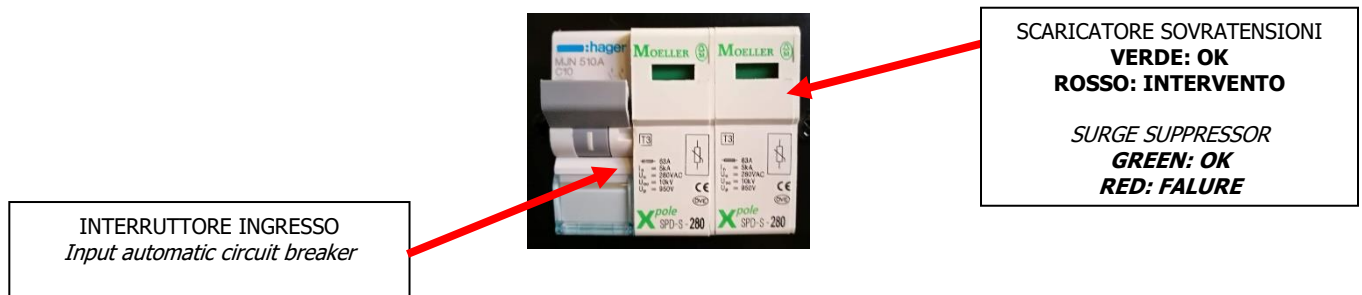
FIG. 4 INTERRUTTORE INGRESSO E SCARICATORE DI SOVRATENSIONI (OPZIONALE) – Input Circuit breaker and (optional) Surge arrester
