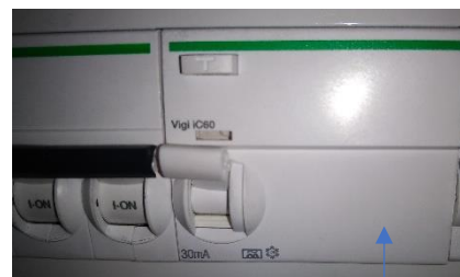
Esempio di Differenziale monofase da 0,5Amp. da collocare tra il Variatore Convertitore Stabilizzatore BB-1.5-SS-R-AU ed Utenza. (con corrente di fuga e tempo di intervento NON regolabile)
